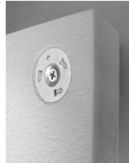
外断熱材の施工では多くの場合、断熱材をビスだけや釘だけまたは両面テープなどで仮押さえされています。しかし、このような仮押さえではかなり不安定です。
